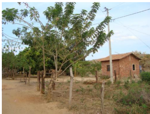
Figura 3- Casa em construção no Assentamento Cachoeirinha, Tumiritinga, MG. 25/09/13
